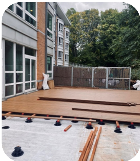
De werkzaamheden aan het terras van het Sint-Lambrechtsstehuis
